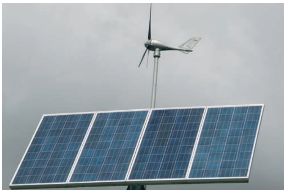
Rys. 3. Zasilanie hybrydowe – panel solarny wspomagany turbiną wiatrową
