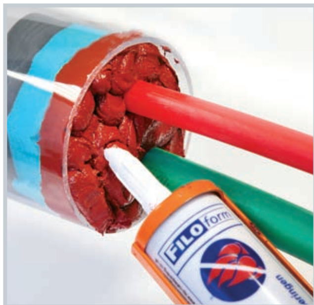
Rys. 6. Instalacja kablowa w trakcie wypełniania komponentem MD+
