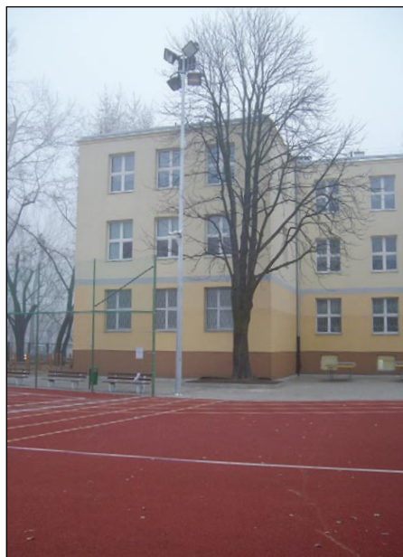
Fot. 2. Projektory Colosseum 1000 W zainstalowane na słupach oświetleniowych wraz z układami zapłonowymi
